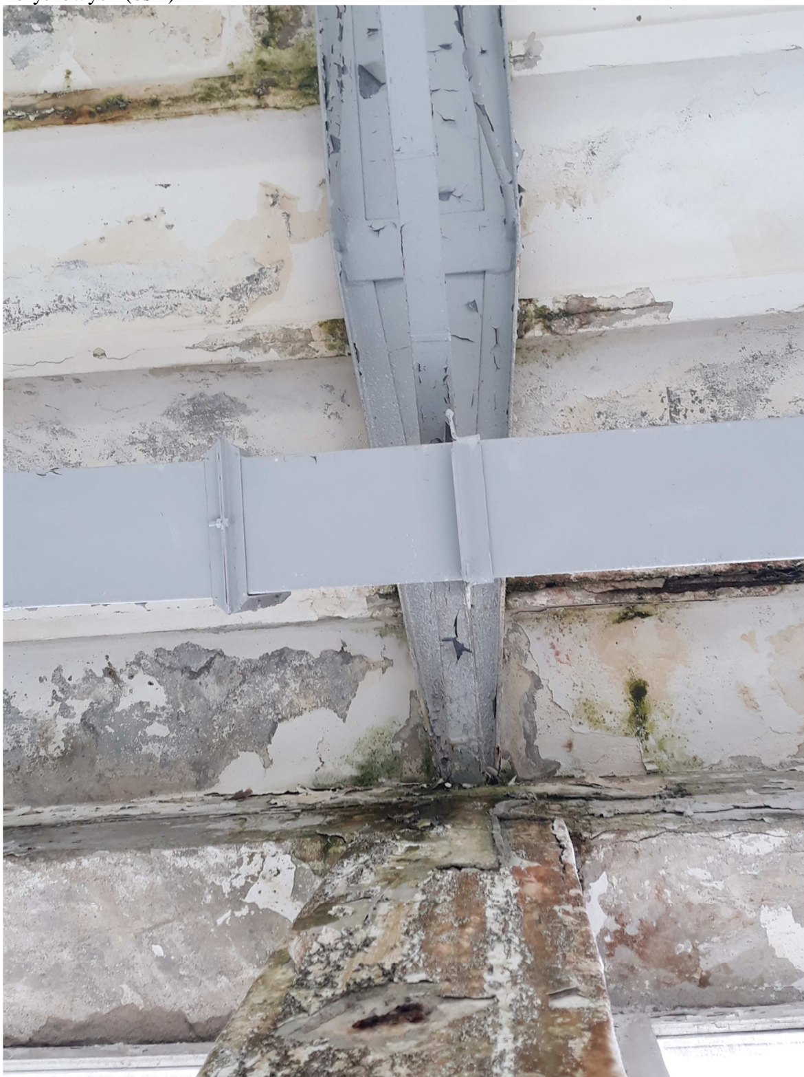
(fot.3). Skutki nieszczelności pokrycia dachowego widoczne na słupie i płytach korytkowych (oś 2)
