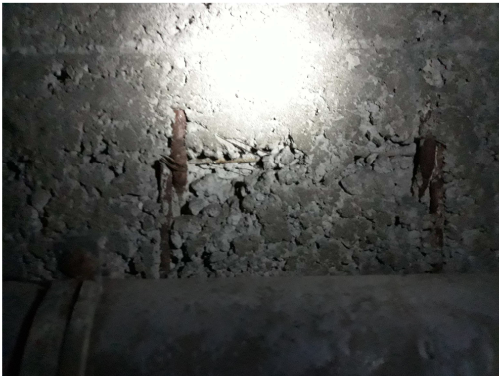
(fot.1). Widoczne pręty zbrojenia niecki basenowej.
