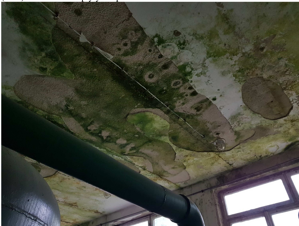
(fot.6). Skorodowane płyty stropodachów
