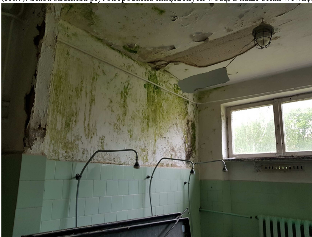
(fot.7). Słaba struktura płyt stropodachu nasączonych wodą, a także ścian wewnętrznych.
