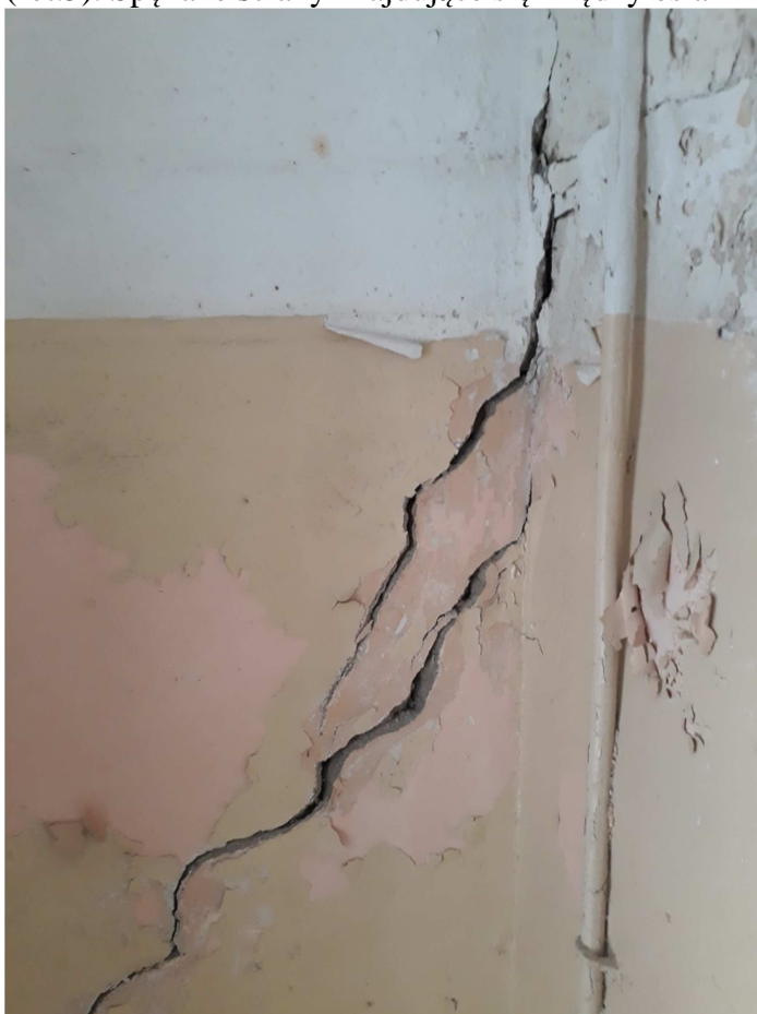
(fot.5). Spękanie ściany znajdujące się między osiami F i G oraz 1 i 2
