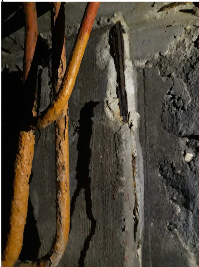
(fot.2). Odpadający beton i skorodowane zbrojenie słupów w osi 1 na wysokości podbasenia
