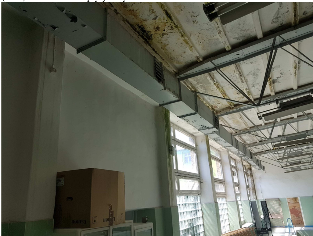
(fot.4). Skorodowane płyty korytkowe.
